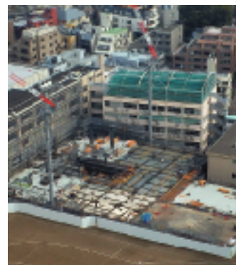
建築中の新校舎(2016年2月撮影) 来年はどうなっているでしょう？
