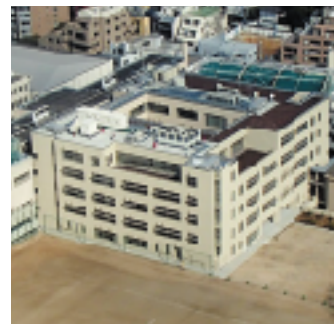
完成した新本校舎 (2017年2月撮影)
